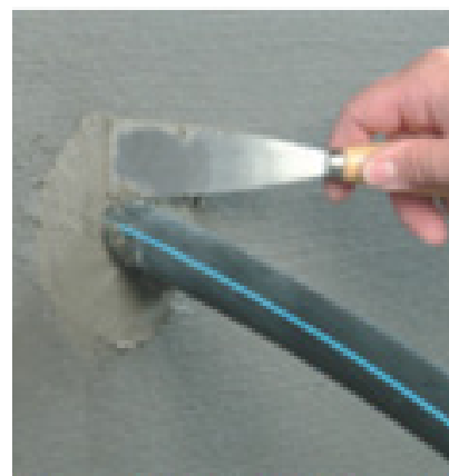
Afslutning med hurtighærdende cement
